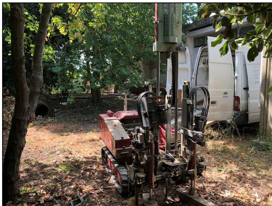
Fig. 7: Postazione della prova penetrometrica Statica/Dinamica PSD.1
