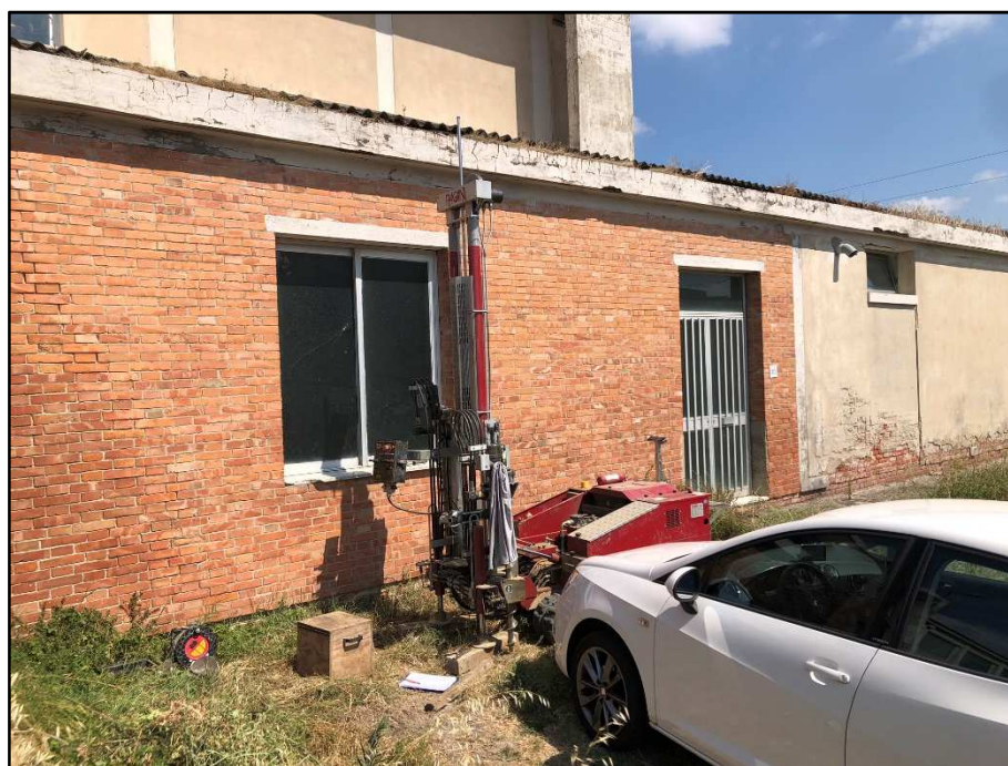
Fig. 8: Postazione della prova penetrometrica Statica/Dinamica PSD.2
